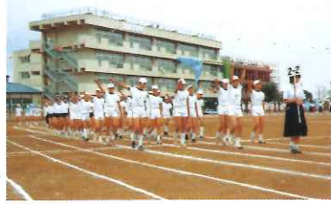
昭和59年 プレハブ校舎と校舎の奥に 新校舎建築中
