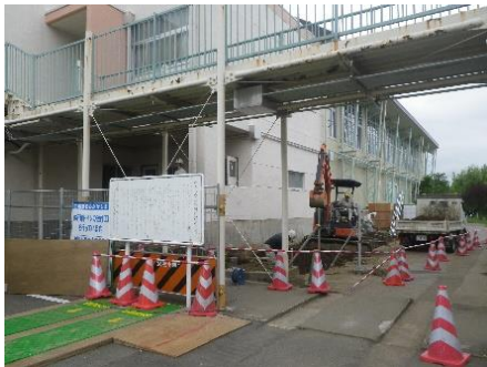
体育館トイレ・スロープ工事開始 9月に完成予定です。しばらく、御不便をおかけします。
