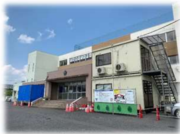
<トイレの工事の準備が進むさかえ小>
